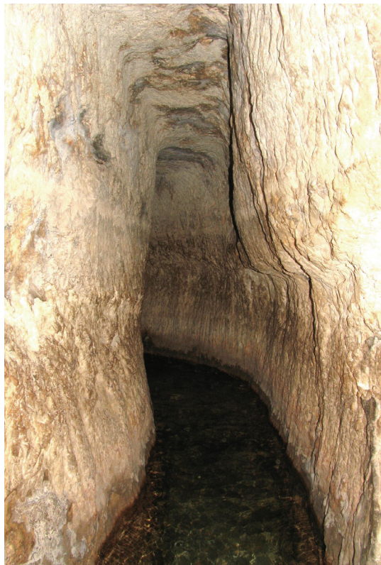
איור מספר 5: הקטע המזרחי של מנהרה VI, מבט למזרח. שימו לב להבדל בין החלק התחתון הרחב לבין החלק העליון הצר (צילום: אשר גרוסברג).
